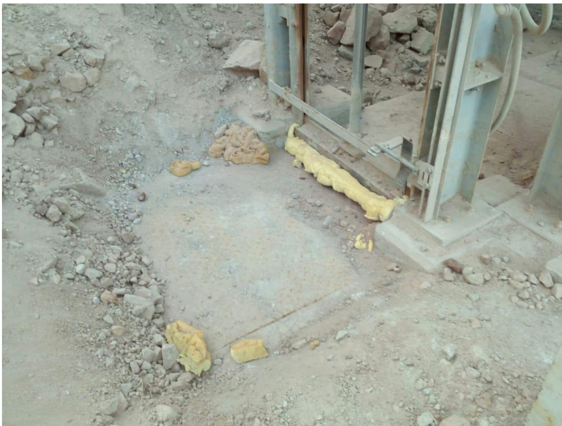
Figura 2-1: Detalle del sellado de la ranura en compuertas IP-A2
